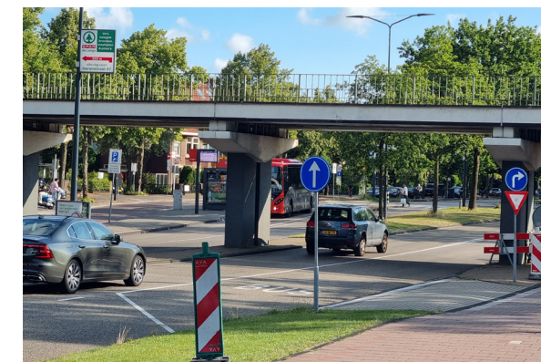
De Lammenschansweg ter hoogte van het spoorviaduct, met de bushaltes waarbij de bus op de busstrook halteert (2023).
