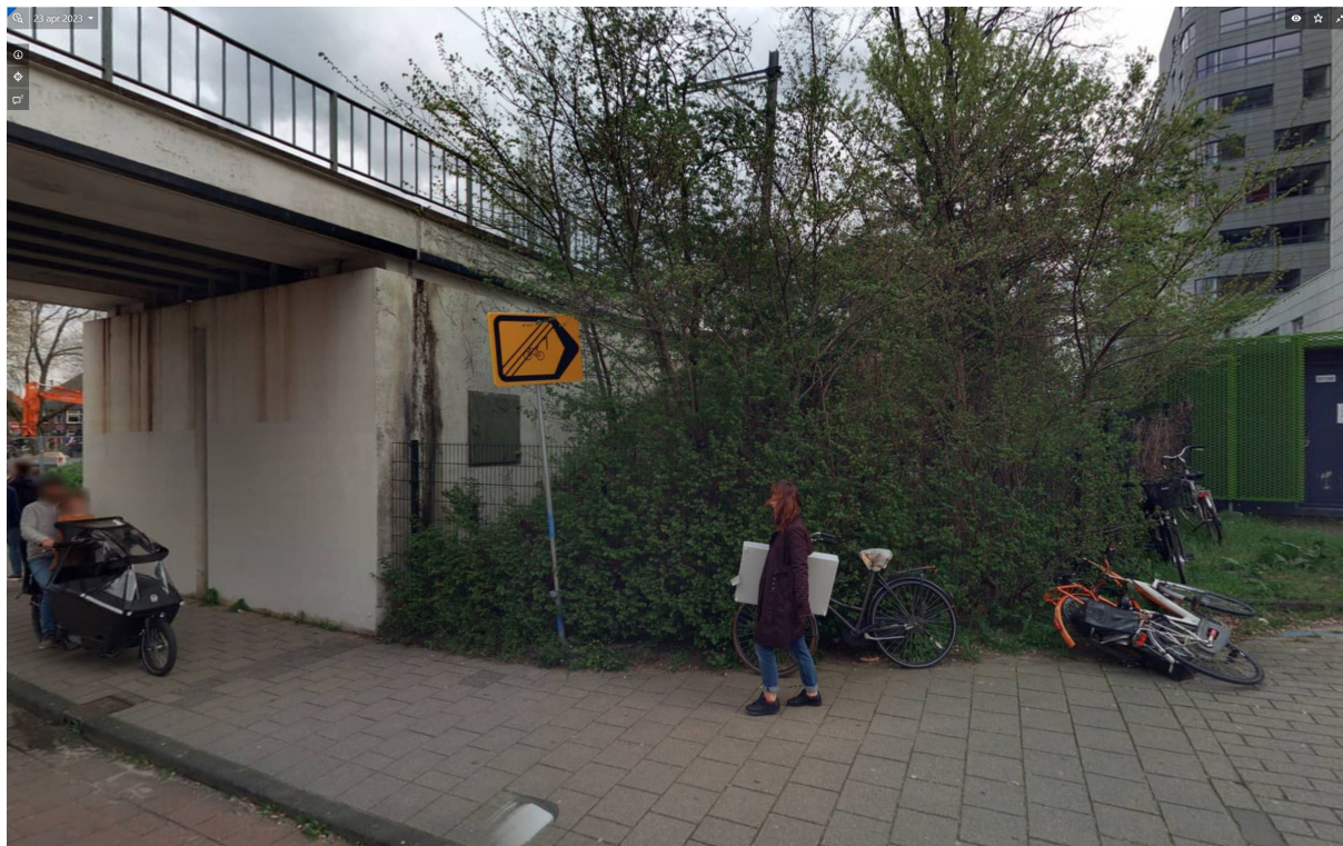
Situatie spoorviaduct bij de Alfastraat (2023). Geparkeerde en omgevallen fietsen in het spoortalud geven een rommelig beeld, net als de fietser over de stoep. Het hek, het bosje, de trafo en het vieze beton geven een gevoel van anonimiteit.
