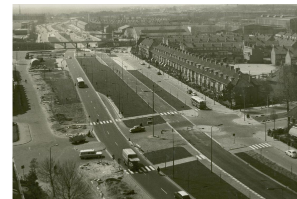
De Lammenschansweg in aanleg (1965)
