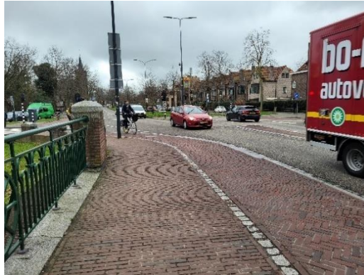
Figuur 25: Kruispunt Zoeterwoudsesingel. Op de Jan van Houtbrug zijn geen hoogteverschillen tussen de verschillende soorten verharding aanwezig.
