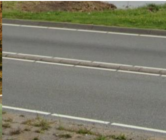
Figuur 29: Voorbeeld fysieke rijstrookscheiding busstrook en reguliere rijstrook.
