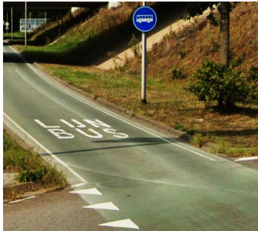
Figuur 30: busstrook van andere kleur deklaag voorzien.
