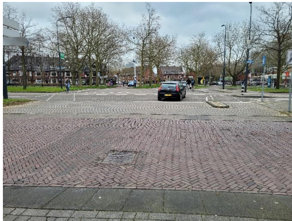
Figuur 16: Kruispunt De Sitterlaan. Aansluiting parallelweg met uitritconstructie.
