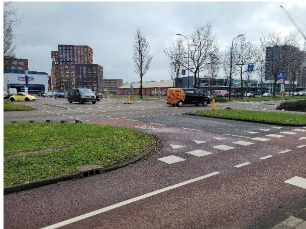
Figuur 8: Kruispunt Tomatenstraat. Reflectiepaal op de middengeleider en gescheiden fietsvoorzieningen.
