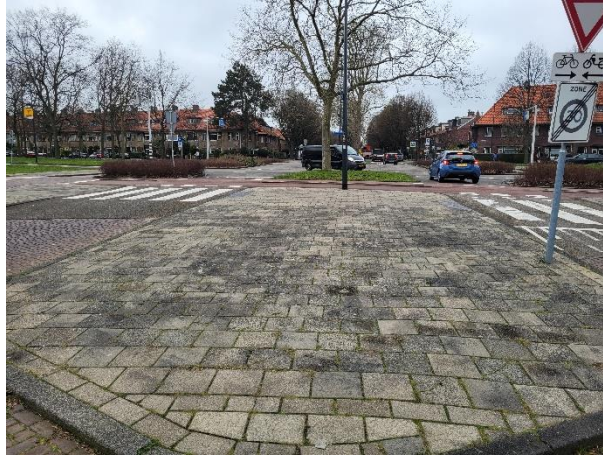
Figuur 19: Kruispunt Koninginnelaan. Aan de Zeemanlaan ligt een breed trottoir zonder functie.
