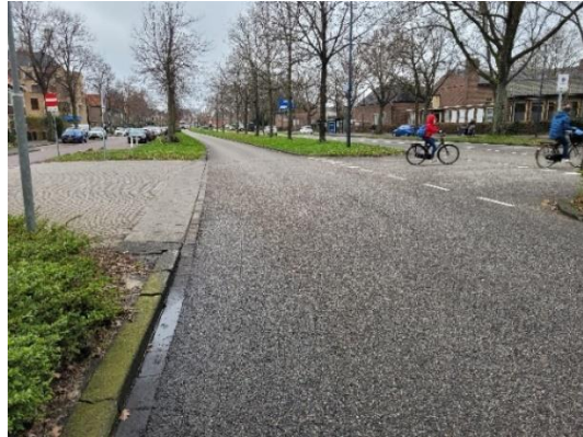
Figuur 21: Kruispunt Leliestraat. Op dit kruispunt zijn geen oversteekvoorzieningen voor fietsers aanwezig.
