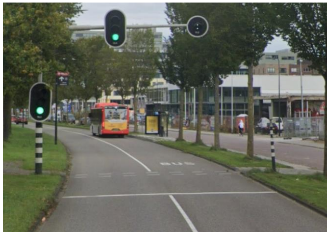
Figuur 34: voorgestelde situatie met zweepmast en negenoog, naar voorbeeld van voetgangersoversteek ter hoogte van Druivenstraat.
