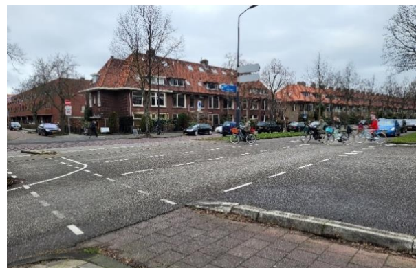
Figuur 14: Kruispunt De Sitterlaan: Markeringen voor de fietsoversteek, de doorgetrokken streep (links) en de busstrook scheiding (midden) leveren een onduidelijke situatie op.
