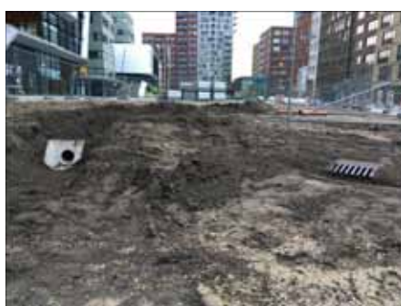
In de groene eilanden zijn wadi's aangelegd voor waterinfiltratie en berging
