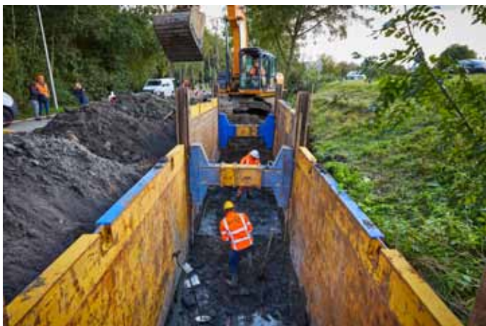
Het graven van de proefsleuf
